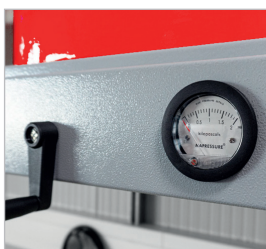
Monitorowanie filtra za pomocą manometru
